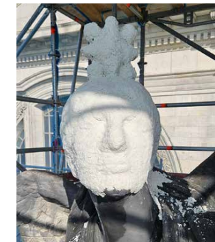
Figurengruppe Liebe, Behandlung mit Ammoniumcarbonat-Kompressen, April 2024 (DG)
