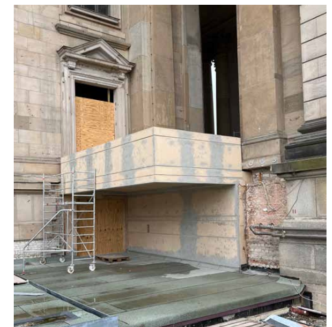
Berliner Dom, Nordseite, Balkon (in Überarbeitung) für barrierefreien Zugang, Juni 2024
