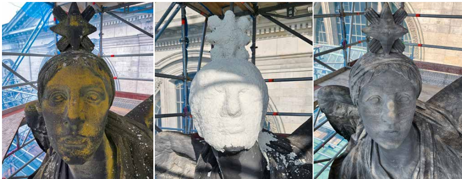
Figur Hoffnung, Vorzustand, Oktober 2023, Behandlung mit Ammoniumcarbonat-Kompressen, April 2024 und Endzustand, Juli 2024
