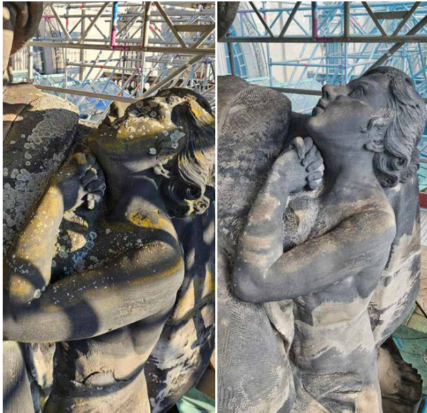
Figur Liebe, Vorzustand, Oktober 2023 und Endzustand, Juli 2024
